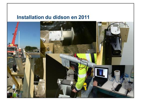
Le didson a été installé en 2011.Il a été monté sur un rail de 12m placé dans l'encoche de reserve dans laquelle s'encastrent les battardeaux de la vanne 4. Le didson est relié à l'ordinateur d'acquision placé en rive dans la passe à poisson par un cable spécifique. Il est descendu le long du rail par un charriot mobile.
