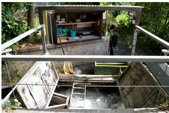
Figure 11: Vue du piège de montée en fonctionnement
