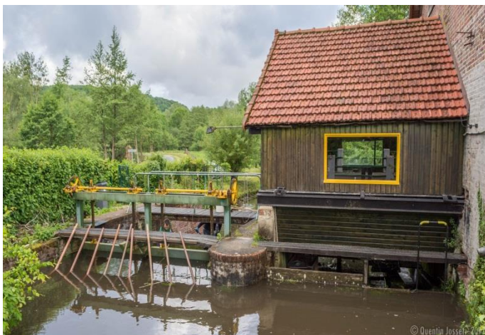
Figure 2 : Vue amont du piège du Lieu-Dieu (Beauchamps - 80)
