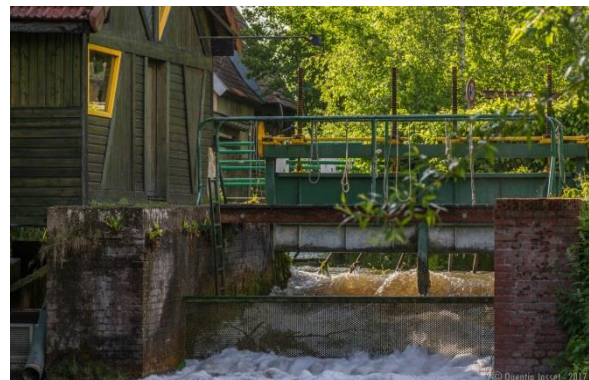
Figure 27 : Vue aval du piège de Beauchamps
