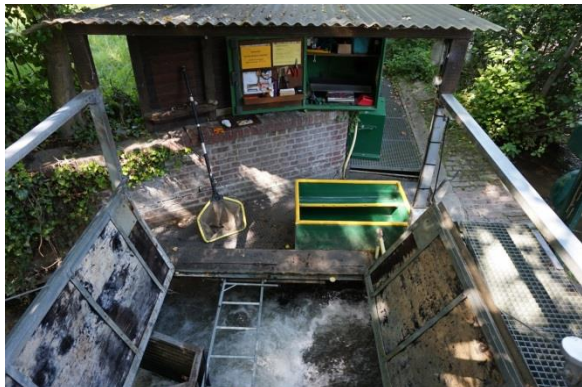
Figure 10: Vue du piège de montée en fonctionnement
