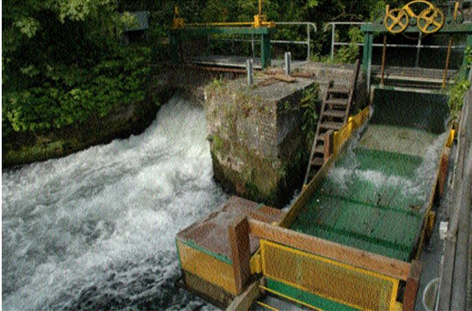
Le dispositif secondaire de capture des poissons d'avalaison a fonctionné du 05 mars au 31 mai 2013.
